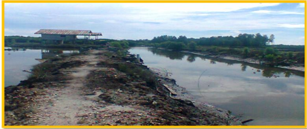
Gambar 13. Kondisi Saluran air utama tambak budidaya biota ganda di Kec Balinggi
