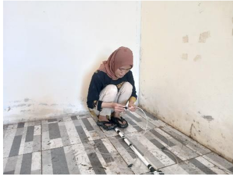
Pemasangan pipa dan aerasi
