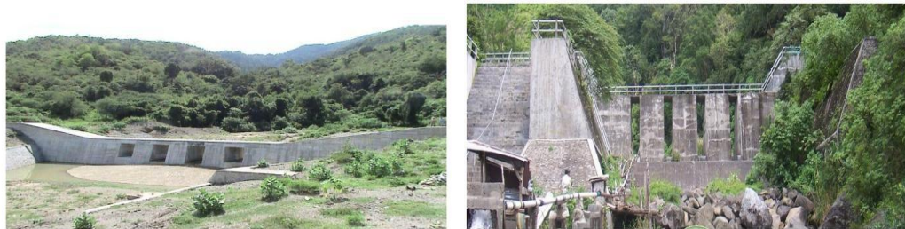
Gambar 2. 2 Bangunan Sabodam tipe Terbuka
