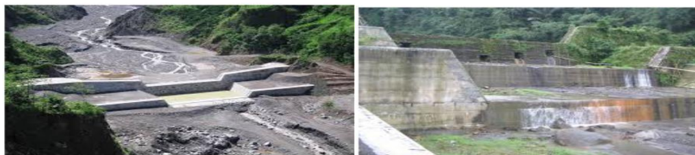
Gambar 2. 3 Bangunan sabodam tipe Tertutup
