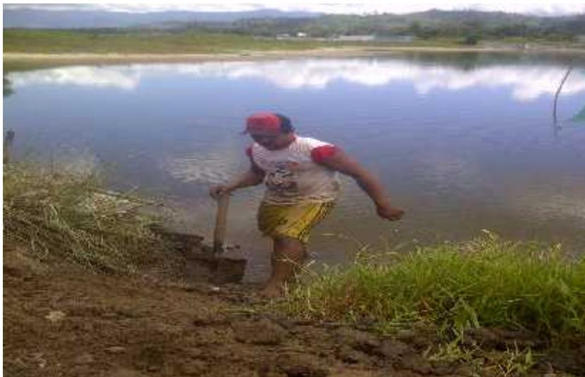
Gambar 2. Perbaikan pematang
